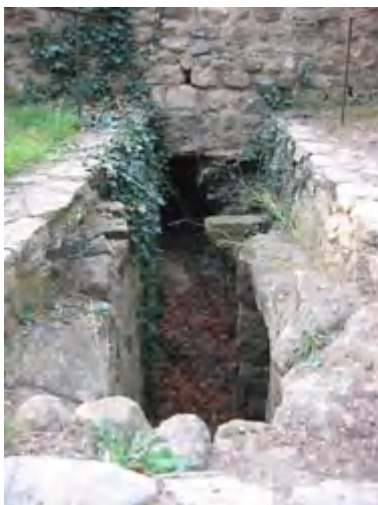
Canalisation passant sous le dortoir des convers
